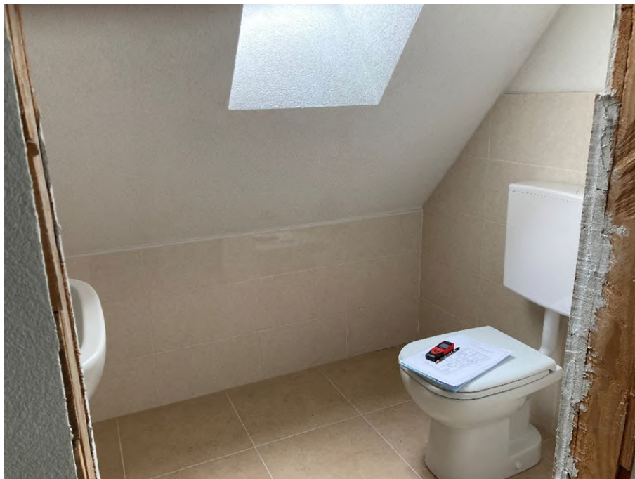
Vista bagno sottotetto
