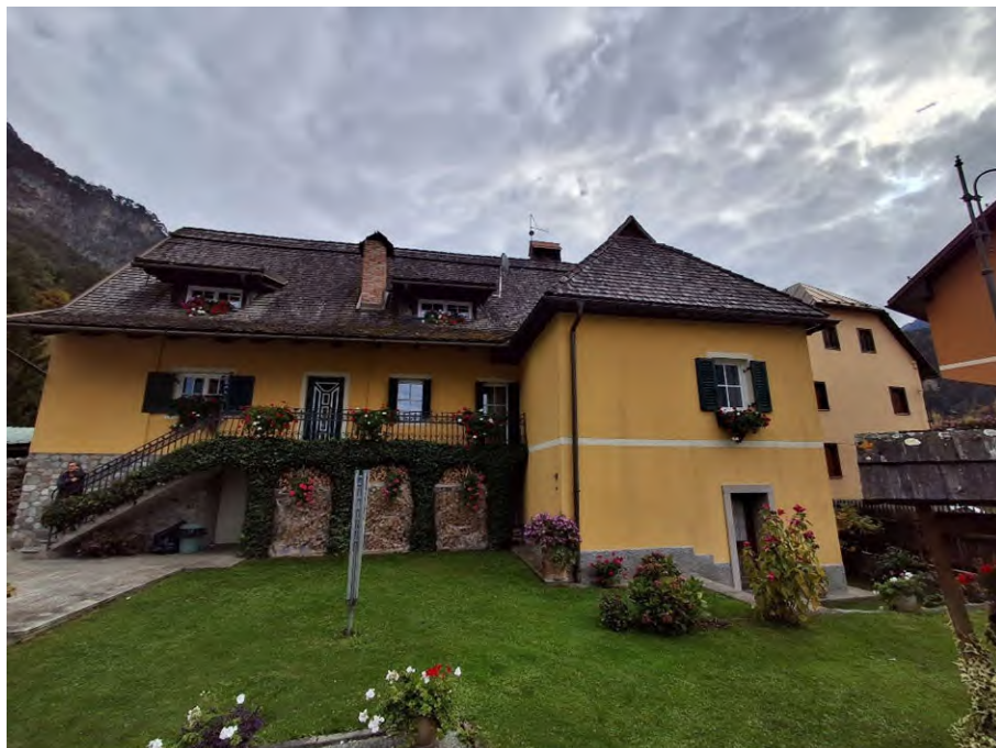
Vista fronte ovest
