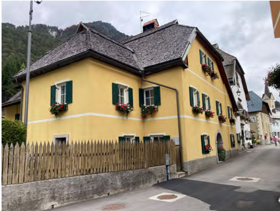
Vista fronte sud-ovest
