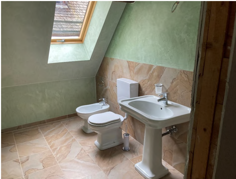
Vista bagno sottotetto
