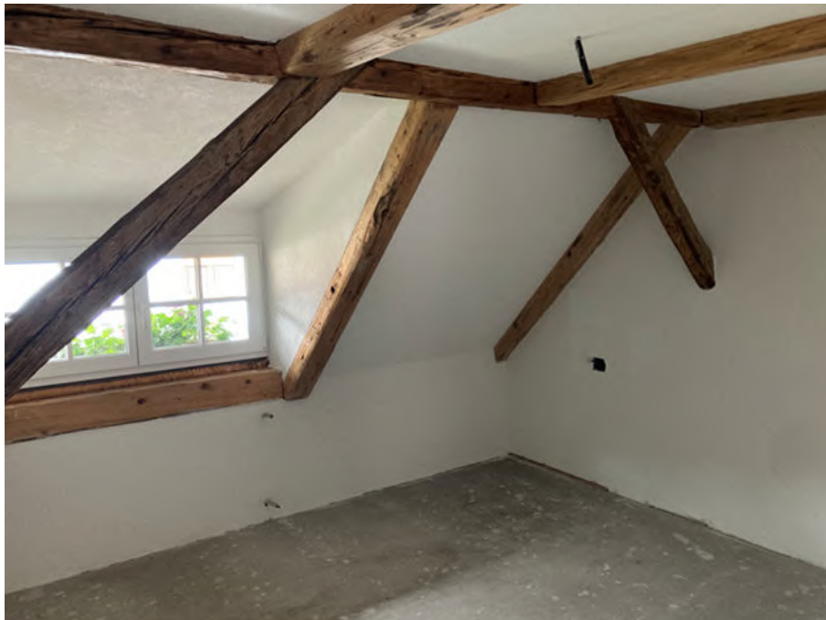
Vista camera sottotetto
