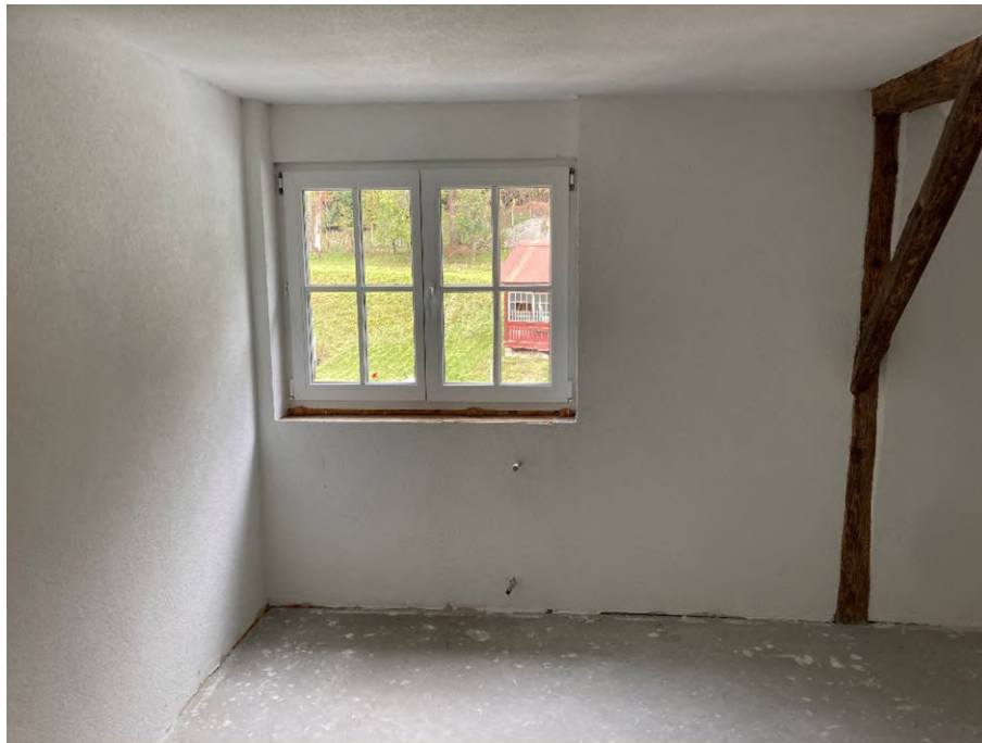
Vista camera sottotetto
