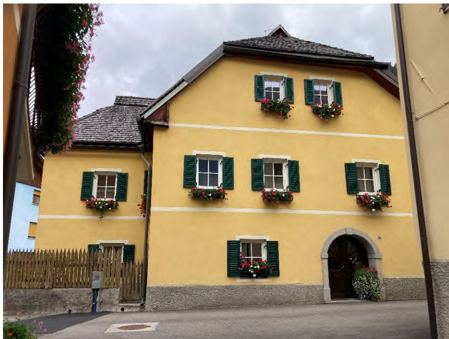
Vista fronte sud
