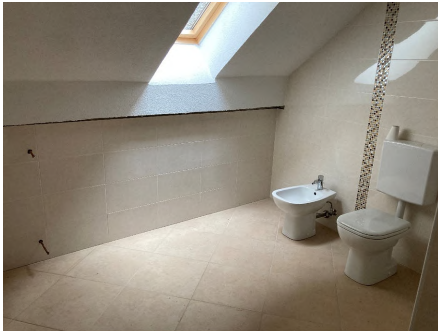
Vista bagno p.1°
